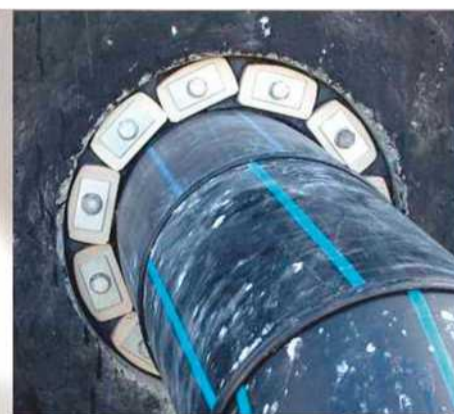
Nyomó csővezeték fi 315.
