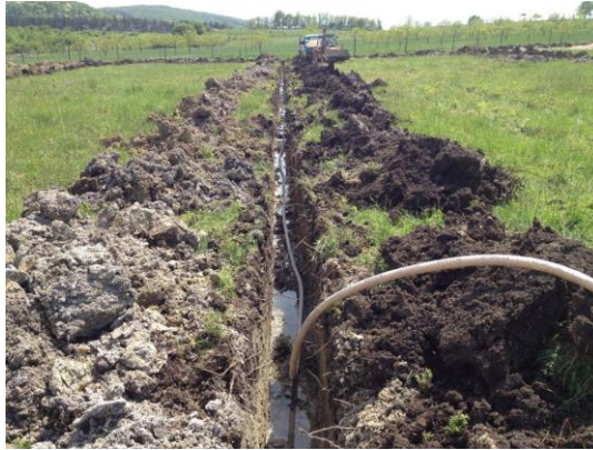
2.kép: Csőfektetés [3]
