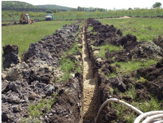
3.kép: Sóderes- kavicsos réteg [3]
